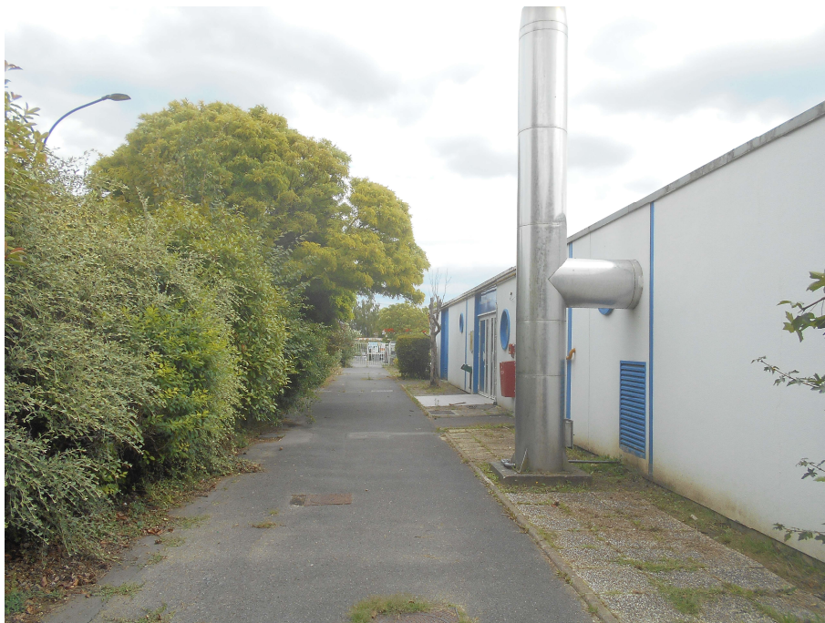
Photo 5 : Vue depuis la voie bordant l'ancienne piscine, au fond l'avenue des Diablots
